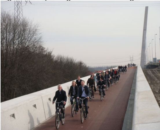
Figuur 4: Opening Muiderfietsbrug
