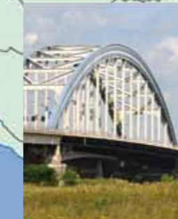
Nederland • Vianen Vredesbrug over de Rijn, 1933, tijdens de Tweede Wereld- oorlog verwoest, in 1948 weer opgebouwd
